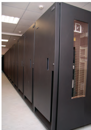
Общий вид части основного оборудования (слева направо: роботизированная библиотека, дисковый массив)
