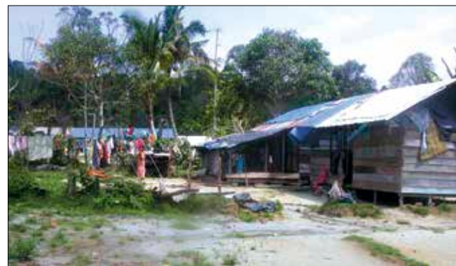
2004-SUMATRA Arriba El pueblo de Langi fue completamente destruido por el tsunami de. Abajo Cuatro meses después, una nueva casa se ha construido sobre los fundamentos dañados.
