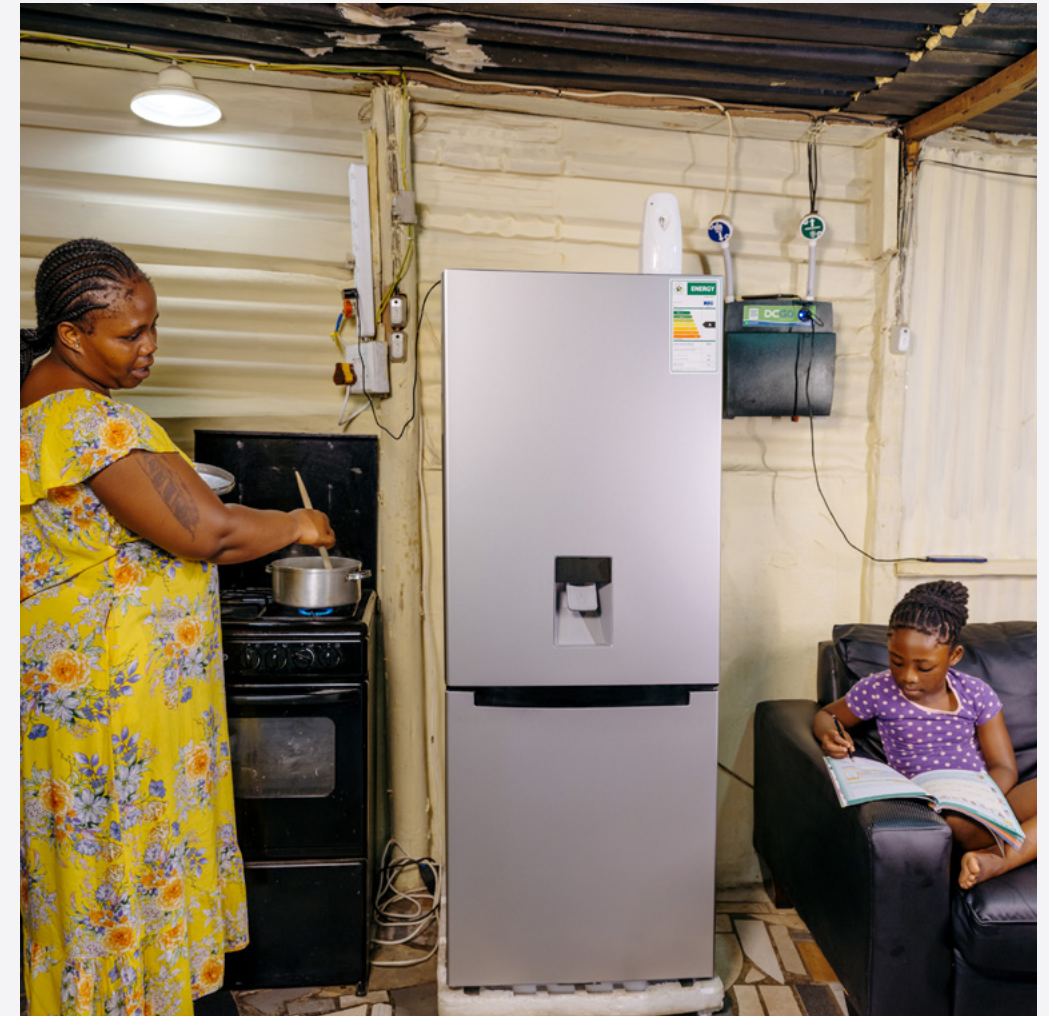
Durch die Stromversorgung in ihren Häusern im Rahmen eines der Projekte in Südafrika können Kinder jetzt abends ihre Hausaufgaben machen und Familien können im Innenbereich Mahlzeiten zubereiten.
