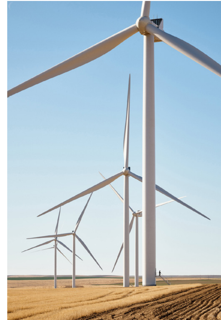
Mit 200 Megawatt ist die Montague Windkraftanlage in Oregon eines der bisher größten Apple Projekte für erneuerbare Energien.
