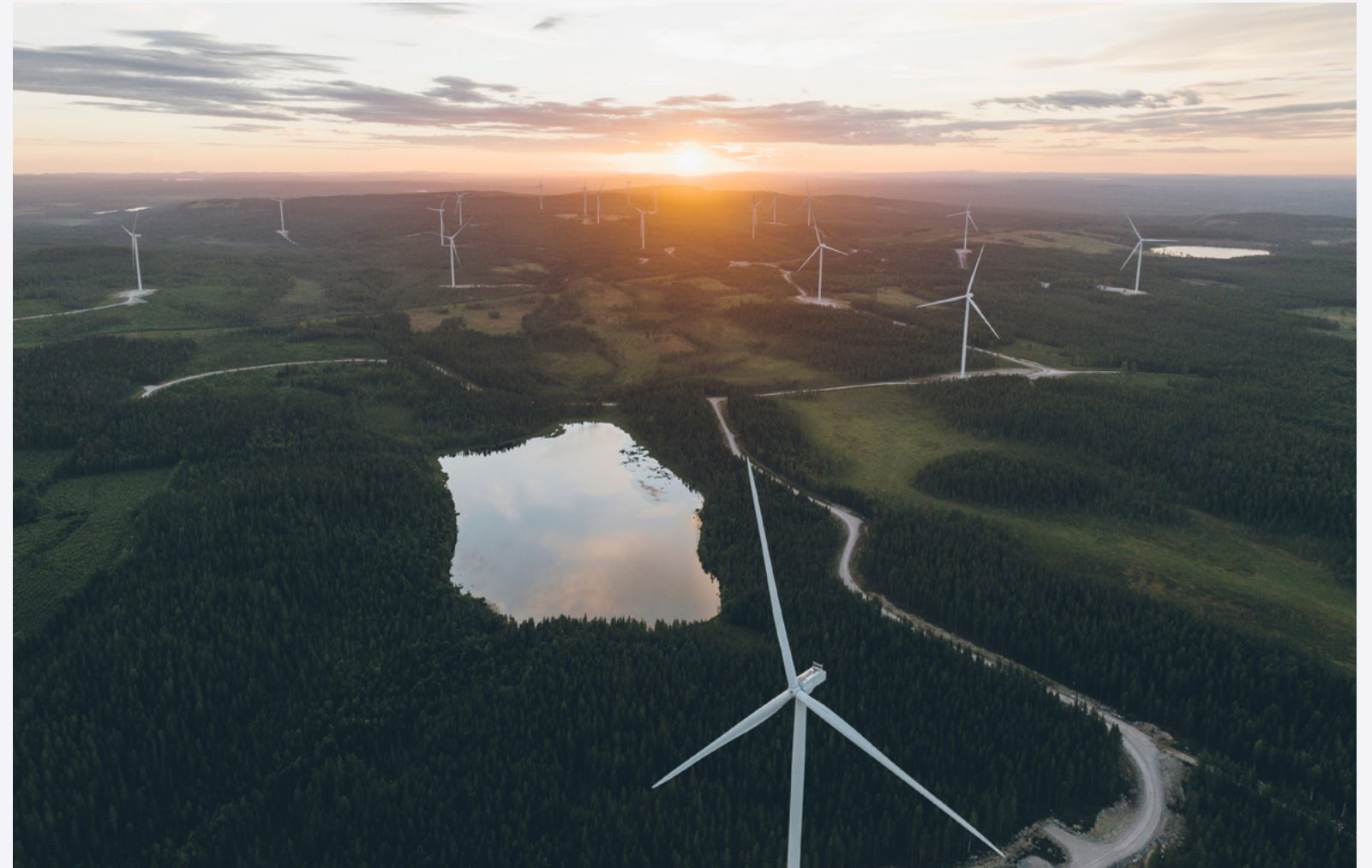
Über 250 Zulieferer haben sich im Rahmen des Clean Energy Programms von Apple dazu verpflichtet, 100 % erneuerbaren Strom für die Apple Produktion einzusetzen. Das schwedische Unternehmen Holmen Iggesund (siehe Abbildung) ist dem Programm 2023 beigetreten.
