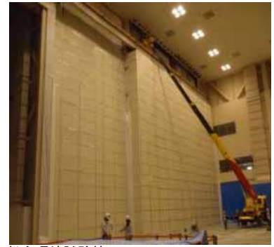
(図4) 総合環境試験棟 「工外用飛散防止パネル」を使用した仮設壁 (仮設クリーンルーム室内側)
