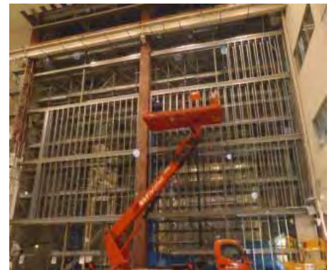
(図6) 総合環境試験棟 組立準備室(4) 仮設クリーンルーム壁を撤去後、 壁骨組みの本格復旧工事中
