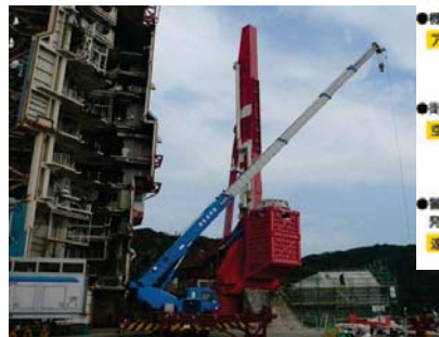
図6 ランチャの改修
