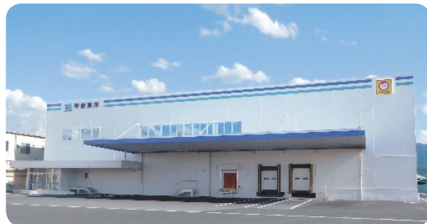
所在地：山梨県中央市布施91 稼働：2018年1月
