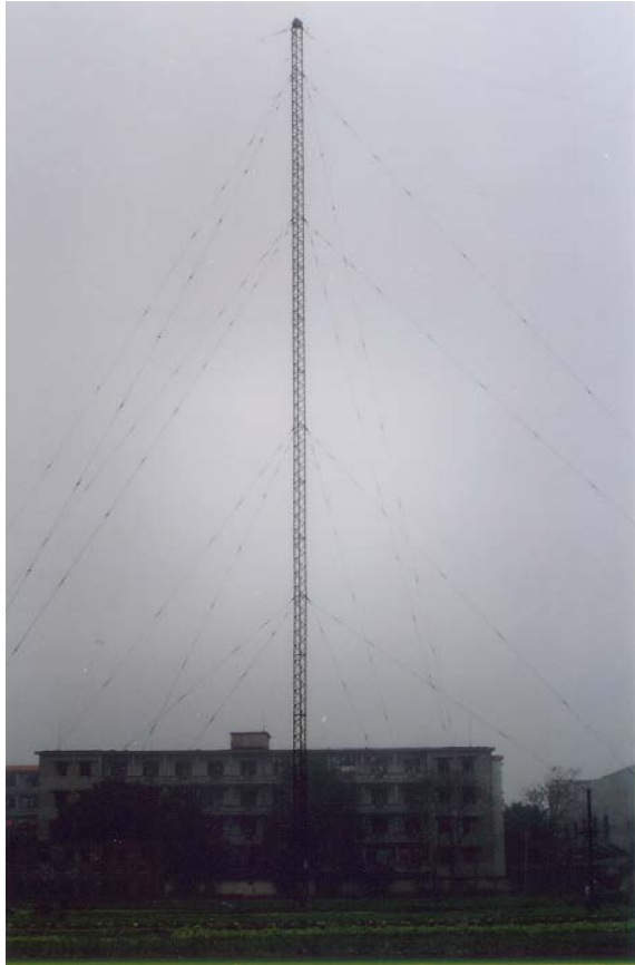
Antenna of Ionosonde
