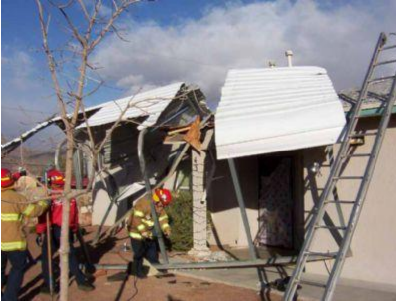
Damage carport in El Paso. El Paso Fire Department for the El Paso Times
