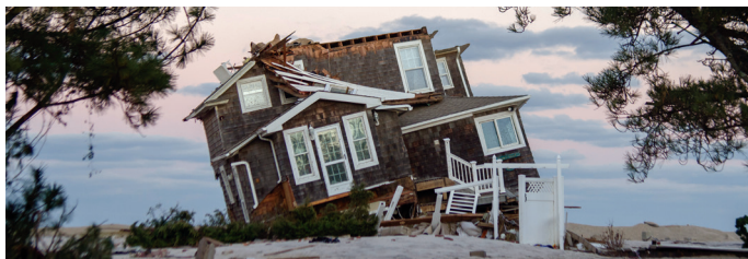
Mantoloking, N.J., 5 de noviembre de 2012 - Esta residencia fue destruida por la devastadora marejada ciclónica del Huracán Sandy. Foto de FEMA
