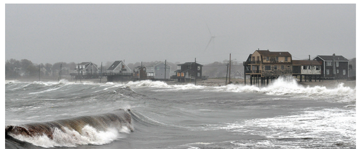
Scituate, Mass., 29 de octubre de 2012 - Las pocas residencias que quedaron en pie luego de la "Tormenta Perfecta" del 1991 están listas para la marejada que está a solo unas horas de llegar. Foto por Marilee Caliendo / FEMA
