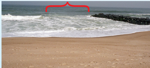
Con frecuencia la corriente marina se origina cerca de estructuras costeras.
