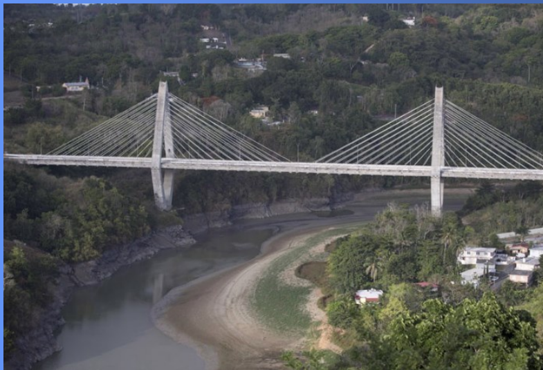
Image 2. Naranjito Bridge. La Plata River. (Image from El Nuevo Dia)
