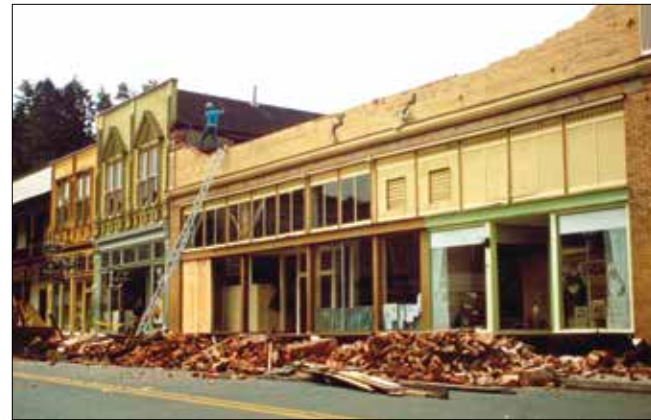
Los ladrillos del mismo edificio se cayeron durante el terremoto de abril de 1992. El edificio ha sido reemplazado por una estructura de madera.
