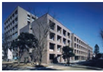
理学系総合研究棟竣工
