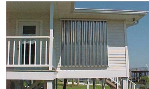
Figura 4-12. Estes painéis de alumínio de calibre 0,050 oferecem proteção contra tempestades econômica. Neste exemplo, os painéis deslizam para uma trilha acima da janela e se fixam em uma trilha inferior usando porcas de asa. Imagem cortesia de Roll-a-way.
