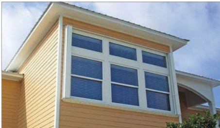
Figura 4-10. Persiana sanfonada (mostrada na posição aberta) instalada sobre uma grande janela de uma casa costeira. A persiana foi instalada para permitir a implantação de dentro de casa. Imagem cortesia de Roll-a-way.
