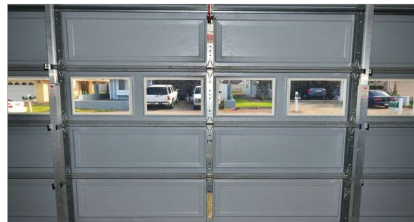
Figura 4-20. Chaves verticais como essas podem ser implantadas durante eventos de vento forte para fortalecer a porta da garagem. As cintas são fixadas desde o cabeçote sobre a porta da garagem até os fixadores instalados no piso de concreto. A implantação e o detalhamento são de cerca de 10 minutos cada. As janelas foram cobertas com uma película laminada. Imagem cortesia de Dennis Hwang.
