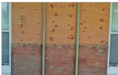
Figuras 4-16 e 4-17. Não só é necessário instalar tampas de abertura de compensado corretamente, mas também é importante rotulá-las corretamente e armazená-las longe do calor e da umidade. Imagens cortesia de Dennis Hwang.
