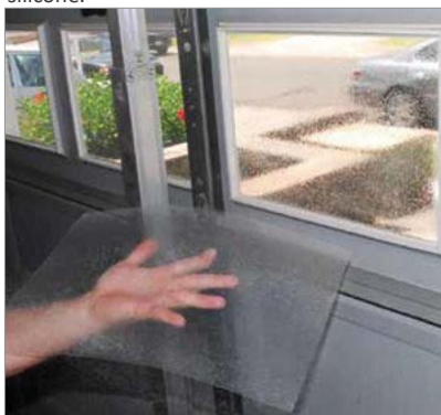
Fig. 4-18. O filme laminado vem em várias espessuras e resistências. Aqui o filme é aplicado em uma janela existente antes de ser fixado à moldura com selante estrutural de silicone.
