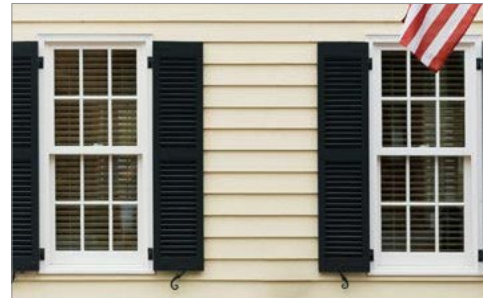
Figura 4-11. As persianas coloniais adequadas para proteção contra tempestades são tipicamente feitas de alumínio ou fibra de vidro. Durante uma tempestade, os painéis são fechados e fixados ao longo do centro vertical da janela. Durante o bom tempo, os painéis se abrem ao longo de dobradiças na lateral da janela e ficam encostados na parede de forma decorativa.
