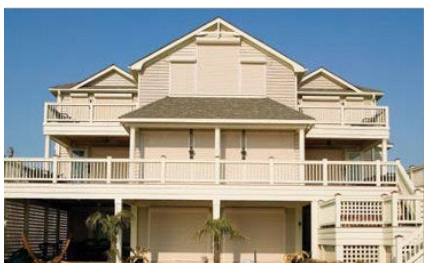
Figura 4-9. Casa costeira protegida com persianas de alumínio em todas as janelas e portas. A persiana é mantida no lugar por guias verticais e pode ser implantada manualmente ou com um motor elétrico integrado. Imagem cortesia de QMI, Inc.
