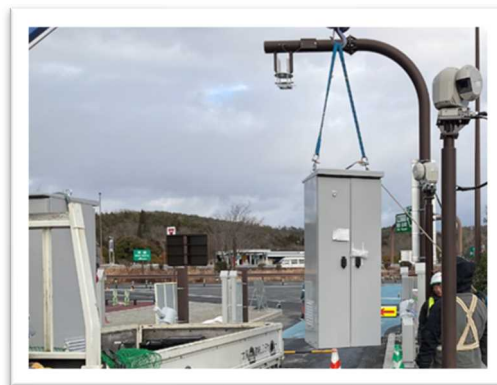
施工中（機器設置）
