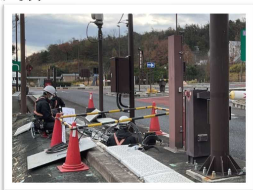
施工中（配線敷設）
