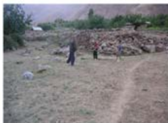
Очистка участка от камней
