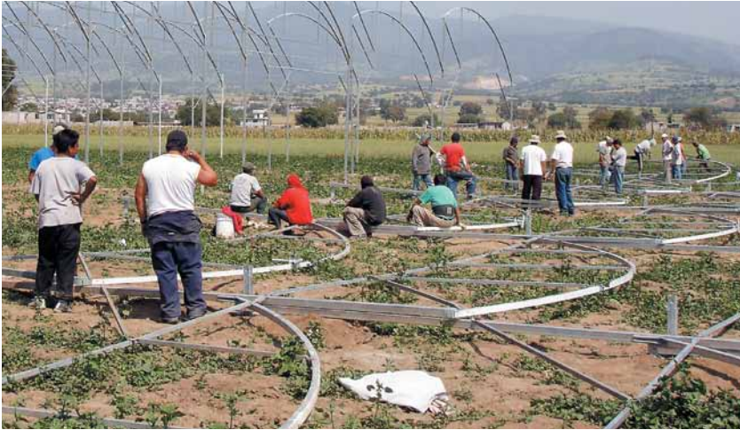
Construcción de un invernadero de un proyecto TeleFood para la producción de tomate en Ixtapaluca, Estado de México./ FAOMX
