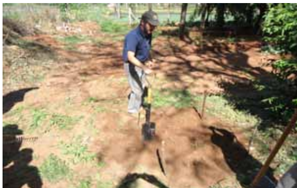
Figura 47 Limpieza del lugar para construir la pila
