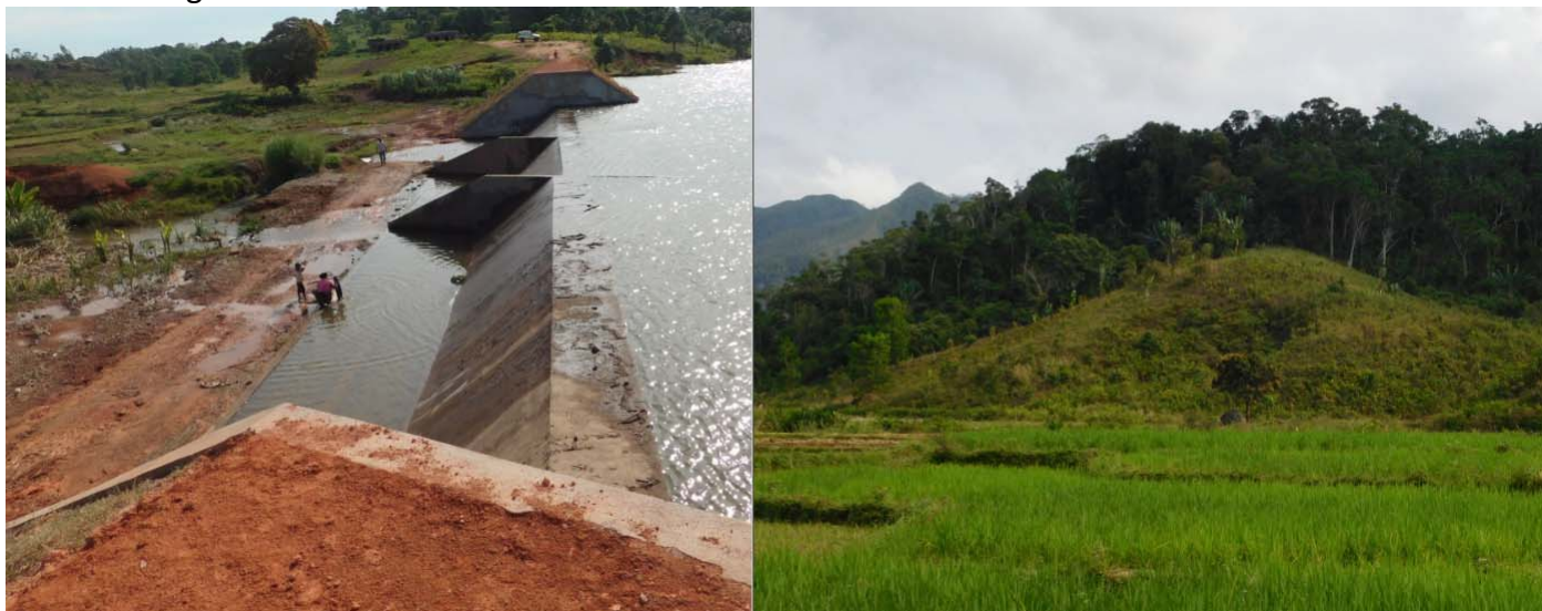
Photos : AINA, 2016 – Barrage d'Andramena à Farafangana et périmètre irrigué d'Agnategny
