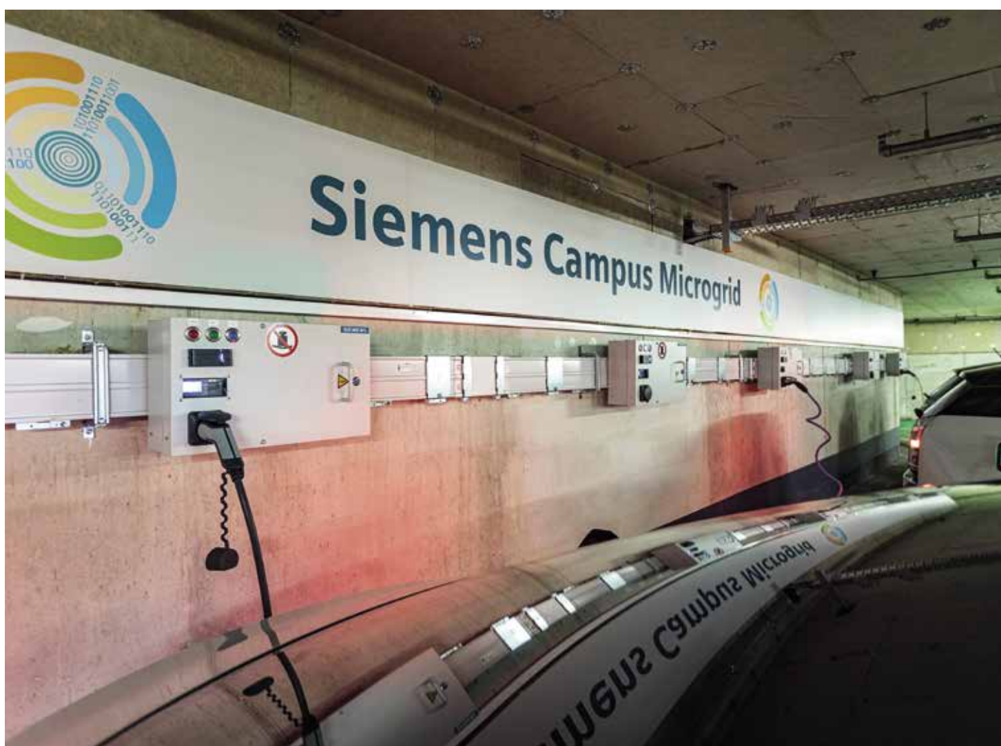
Im Siemens-Microgrid kommen E-Ladelösungen für jeden Leistungsbereich zum Einsatz, darunter der Compact Power Charger mit 50 kW DC-Leistung oder eine modular erweiterbare Stromschienenlösung für Garagen.
