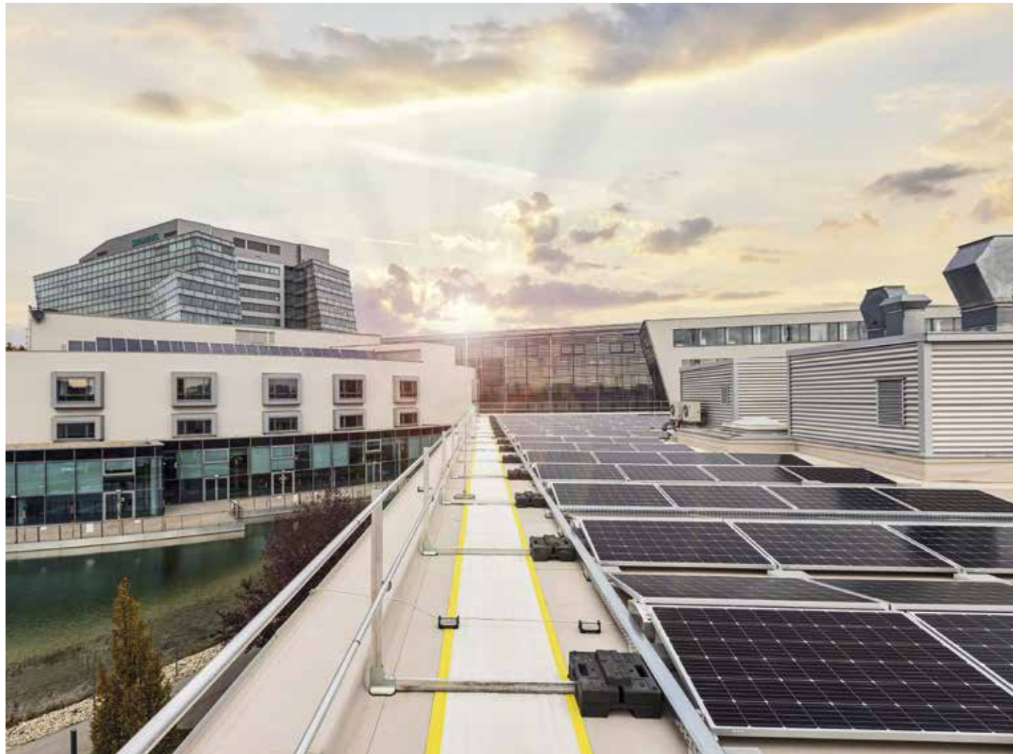
Die in das Siemens-Microgrid integrierten Photovoltaikanlagen umfassen eine Fläche von 1600 m 2 . Mit rund 100 Tonnen CO 2 pro Jahr reduzieren sie den CO 2 -Footprint des Unternehmens.
