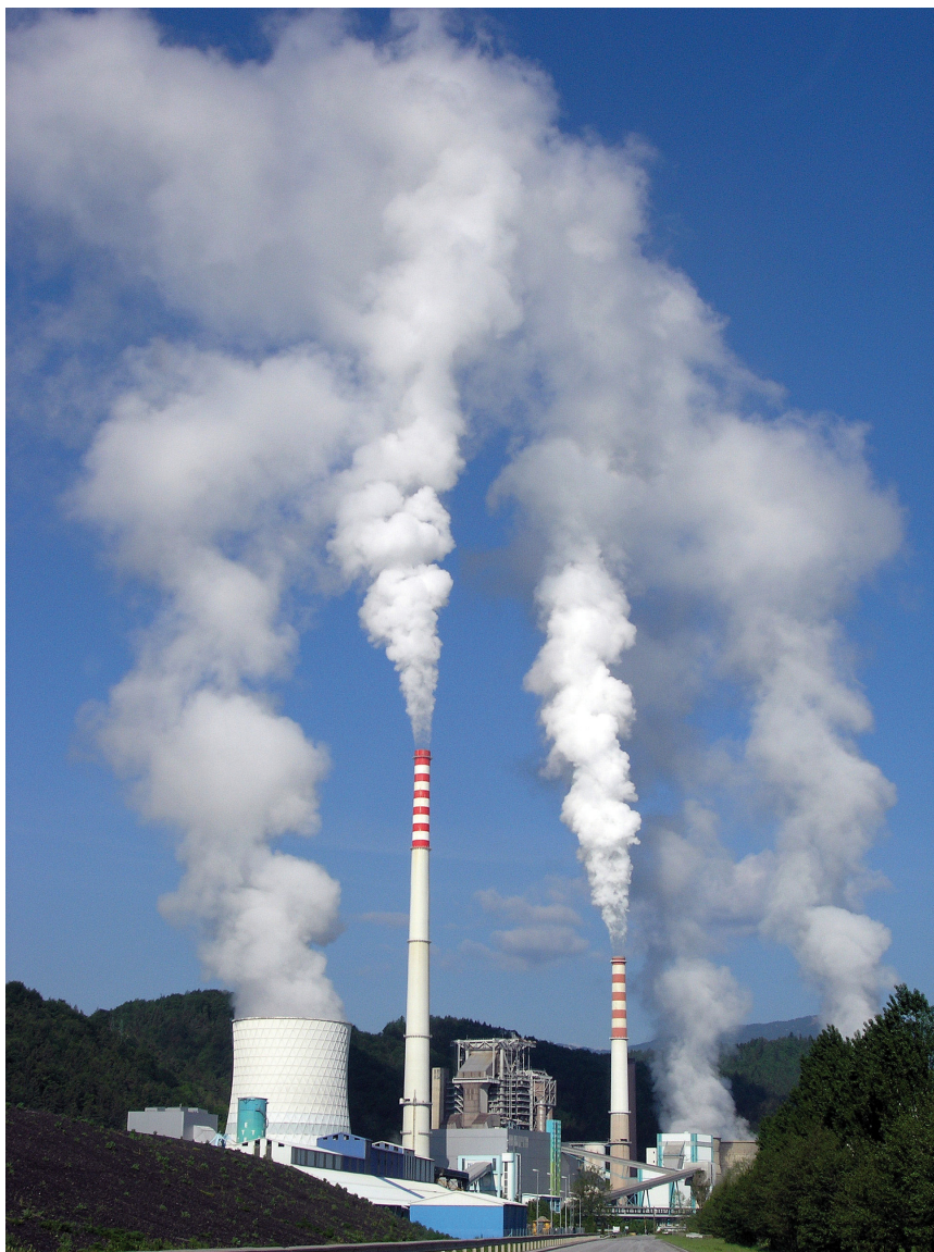
Termoelektrarna Šoštanj, Foto: Iztok Sinjur
