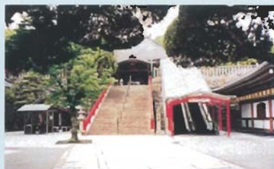
寺院本堂前参道階段とエスカレーターの併設
