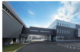
石狩データセンター 3号棟
