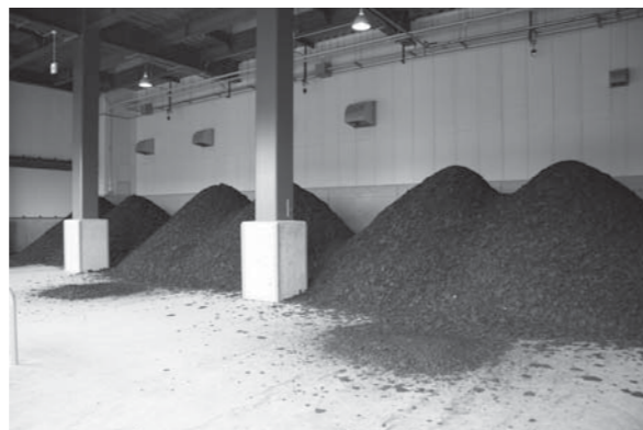
図5 ストックヤードに保管されている脱水ケーキ Fig.5 Dewatered sludge in stock yard
