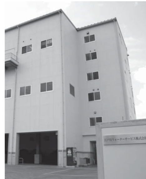
図1 江戸川ウォーターサービス建屋外観 Fig.1 Appearance of Project office
