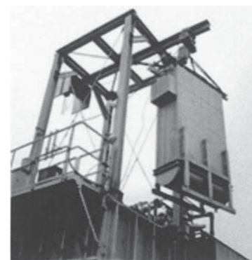
図7 膜ユニット吊上げ状態 Fig.7 Hanging state of membrane unit
