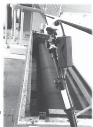
図8 ベルト濃縮機のケーキ排出部に設置した監視カメラと固定アーム Fig.8 Monitoring camera and arm for fixation set up in sludge discharge part of belt thickener
