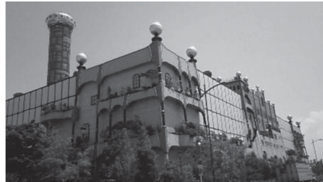
図3 舞洲スラッジセンター外観 Fig.3 Overview of Maishima Sludge Center
