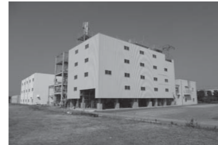
図5 相模川流域右岸処理場焼却設備の外観写真①
