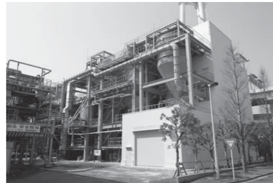
図3 葛西水再生センター焼却設備の外観写真②
