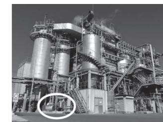
図4 サンエコサーマル廃熱回収設備全況 Fig.4 Waste heat recovery facility of Sun Eco Thermal
