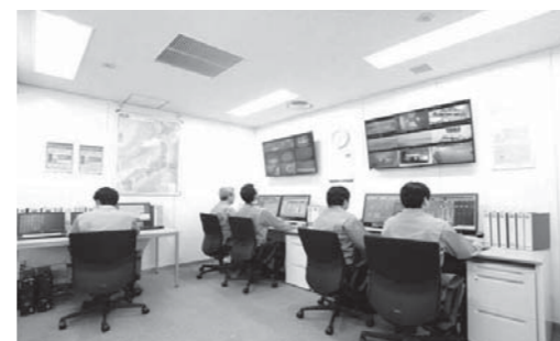
図1 集中監視センター室内 Fig.1 Centralized monitoring center room
