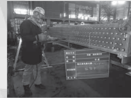
写真2 エアフィンクーラー リチューピング photo2 Air fin cooler retubing
