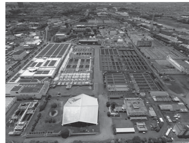
図1 鳥羽水環境保全センター全体 Fig.1 External View of Toba Wastewater Treatment Plant.
