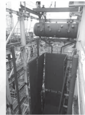
写真4 ボイラー組立 photo4 Boiler installation
