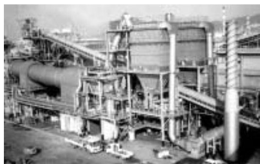
図1 コークス炉石炭用乾燥調湿設備 Fig.1 photo of CMC
