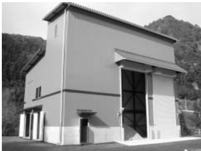
図1 秩父市殿向け木質バイオマスガス化発電・熱併給設備全景 Fig.1 External view of Chichibu CHP facility
