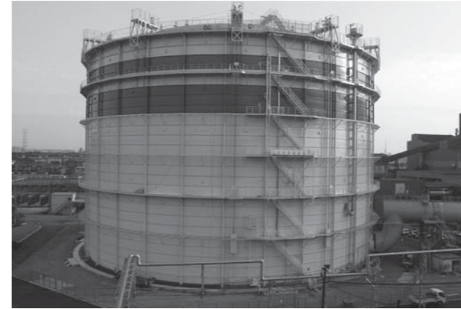
図1 月島ードライシールガスホルダ全景 Fig.1 External view of Tsukishima- Dry Seal Gas Holder
