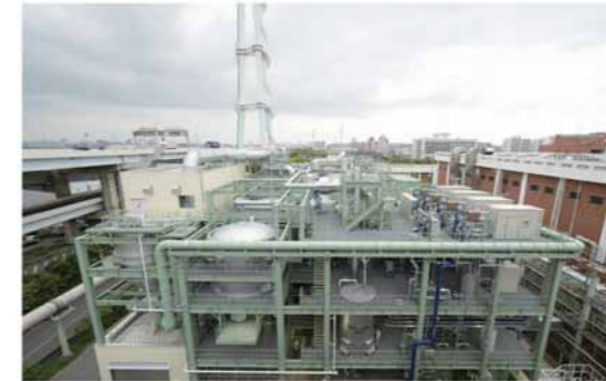
図1 エネルギー自立型焼却炉外観（葛西水再生センター） Fig.1 Appearance of energy independent incinerator (Kasai Water Reclamation Center)
