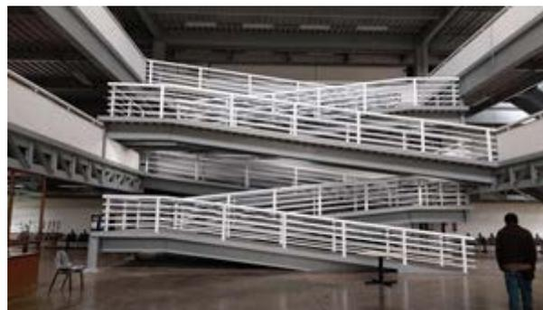
**Figura 26 - Adequação e pintura dos guarda-corpos e corrimãos da rampa – PVB.**
