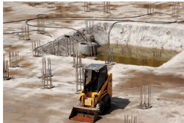
Baugrube im Grundwasserbereich
