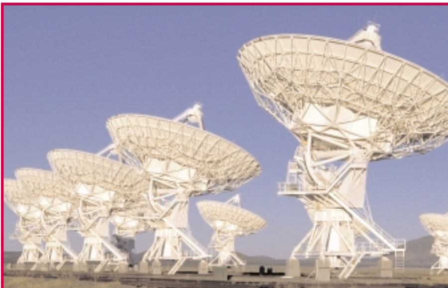
Satellite antennae array
