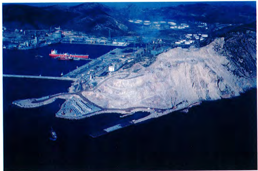
Comienzo del dique sur. Se han situado los tres primeros cajones
