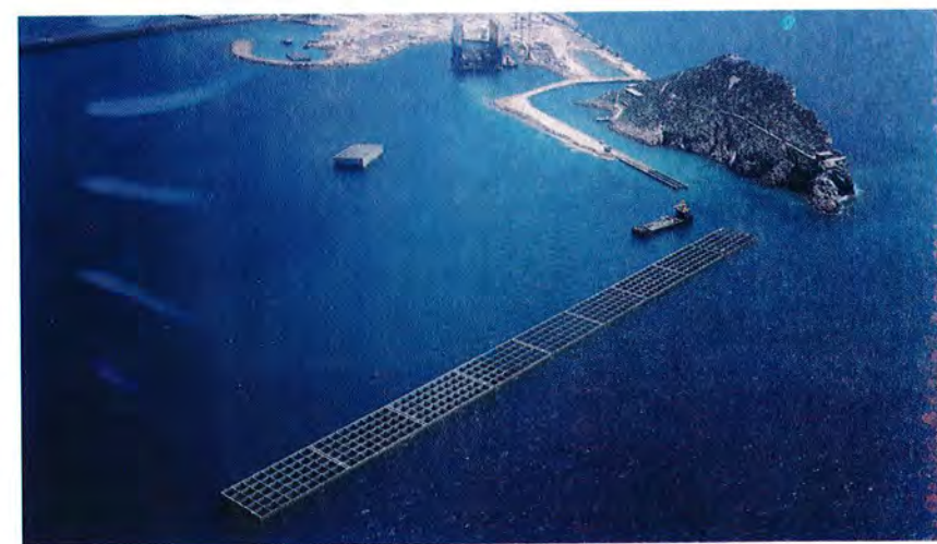
Dique sur y perimetral completados. Colocados los nueve primeros cajones del dique suroeste
