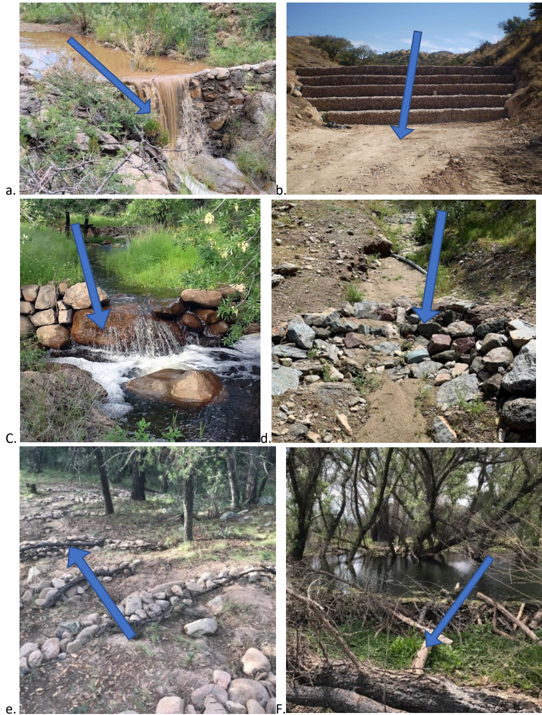
Figura 2. Ejemplos de INATS hechos por humanos y castores, que incluyen a) vertederos con fugas (foto de Josiah Austin), b.) gaviones (Foto de Andrea Prichard (Norman et al., 2010b) , c.) presas de contención (foto por Jeremiah Liebowitz), d) presas de una roca (Foto por Deborah Tosline (Tosline et al., 2020) ); e.) trincheras (Foto de Valer Clark), y f.) un dique de castores, donde las flechas azules representan la dirección del flujo.
