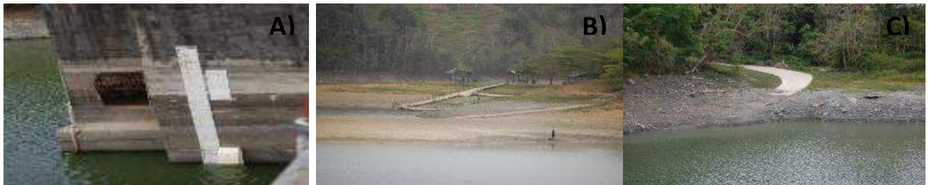
Ilustración 9. A) El nivel de agua en el embalse era de 44.2 m. B) las instalaciones de pesca, como la plataforma de pesca, y C) al igual que la rampa para embarcaciones de la AAA perdieron su funcionalidad debido a que quedaron lejos de la línea de orilla.
