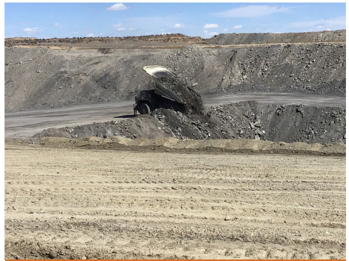
El Segundo Mine Active Reclamation 2024
