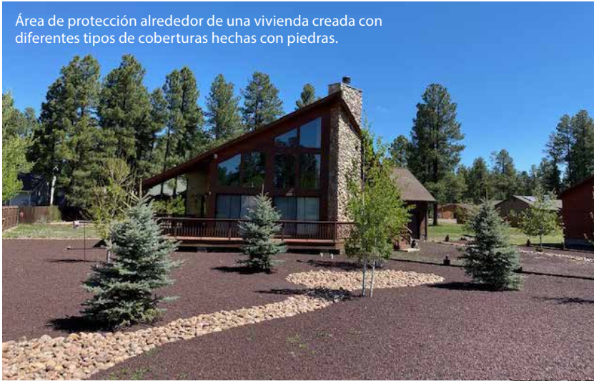
El área de protección funciona con vegetación resistente al fuego bien mantenida.
