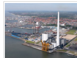
La centrale électrique d'Esbjerg, une installation de captage de CO 2 située au Danemark. Source: DONG Energy
