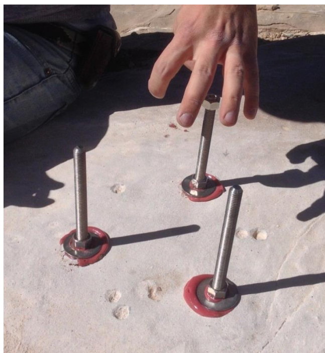
Fig 13: llenado de agujeros con resina epóxica
