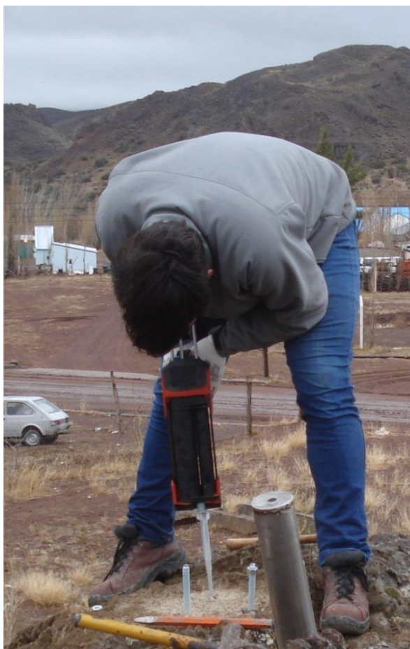
Fig 12: llenado de agujeros con resina epóxica
