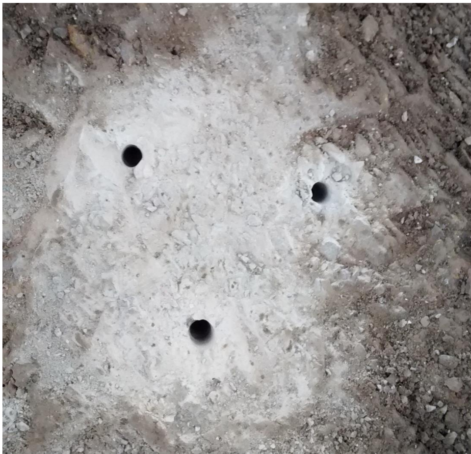
Fig 10: agujeros dispuestos a 120° entre sí.
