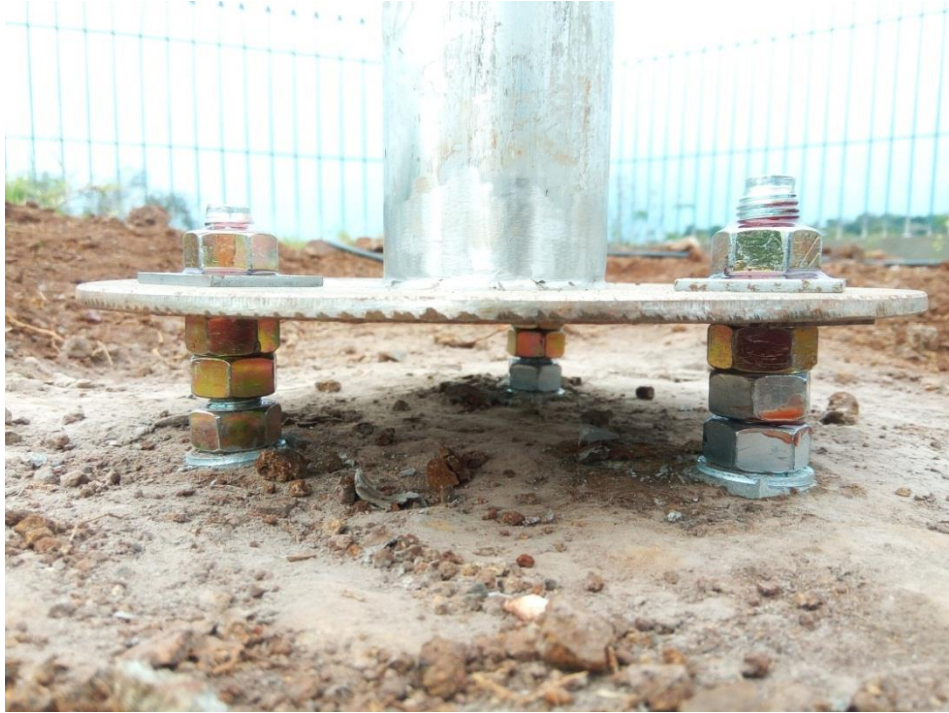
Fig 14: Disposición de tuercas y arandelas.
