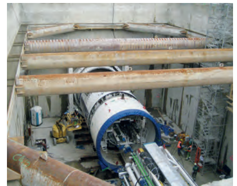
Aufbau der Tunnelvortriebsmaschine im Startschacht DESY Hamburg 2010. (Foto: P. Kudella, KIT)
