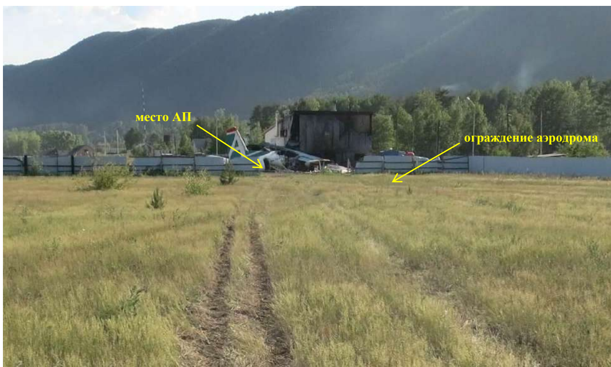
Рис. 14. Разрушенное ограждение аэродрома
