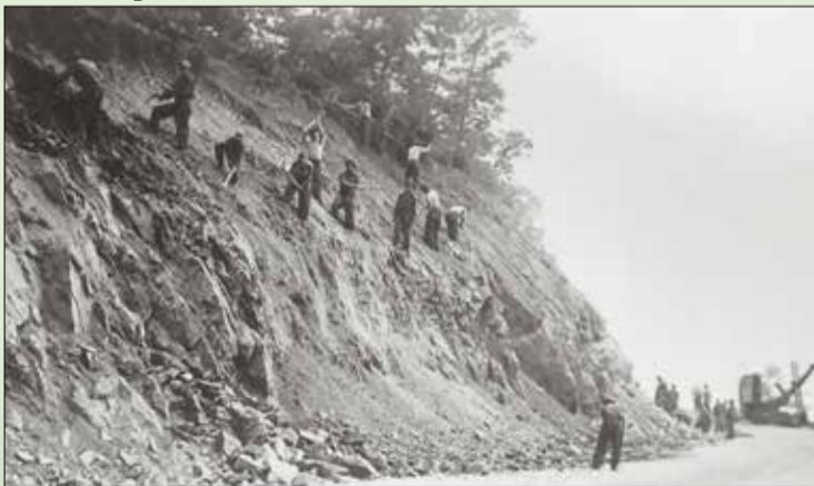
Рабочие корпуса CCC на строительстве защитных сооружений от размыва почвы вдоль Скайлайн-драйв. NPS / RYCKOFF — NPS / ED KNEPLEY
