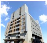
リニューアルされた 都立産業貿易センター台東館
