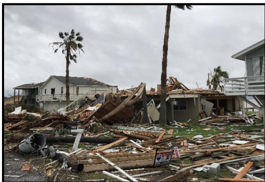
Arriba: Daños a la comunidad de Copano Village en el Condado de Aransas, TX tras el paso del Huracán Harvey en el 2017.
